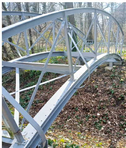
Die Stahlbogenbrücke im März 2024.
